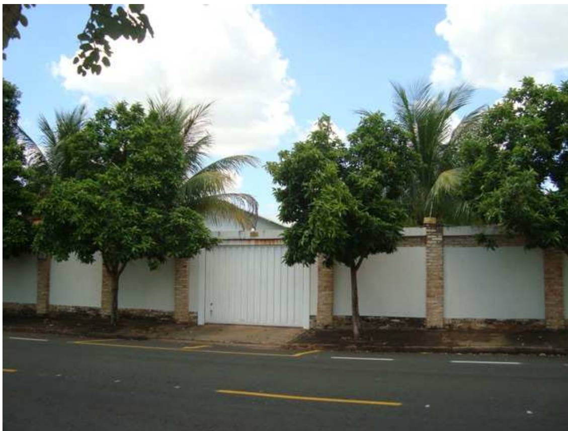
FOTO 02 – Vista do imóvel.
