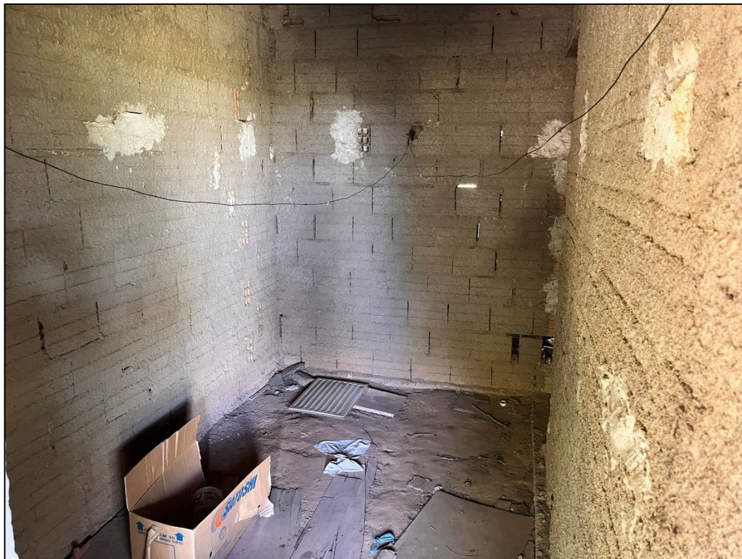
Figura 22 - Vista geral interna
