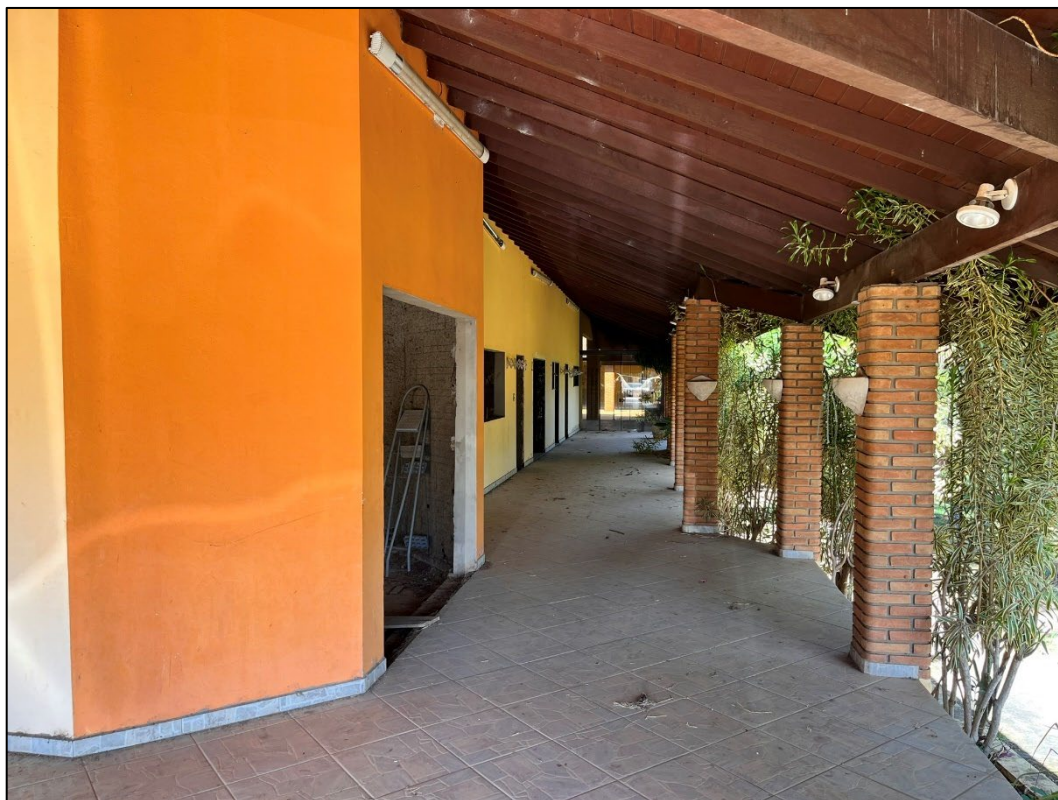
Figura 13 - Vista geral externa
