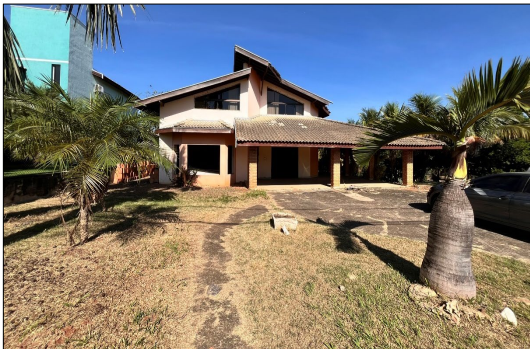
Figura 3 - Fachada do imóvel objeto da presente avaliação
