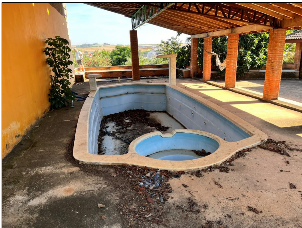
Figura 16 - Vista geral externa
