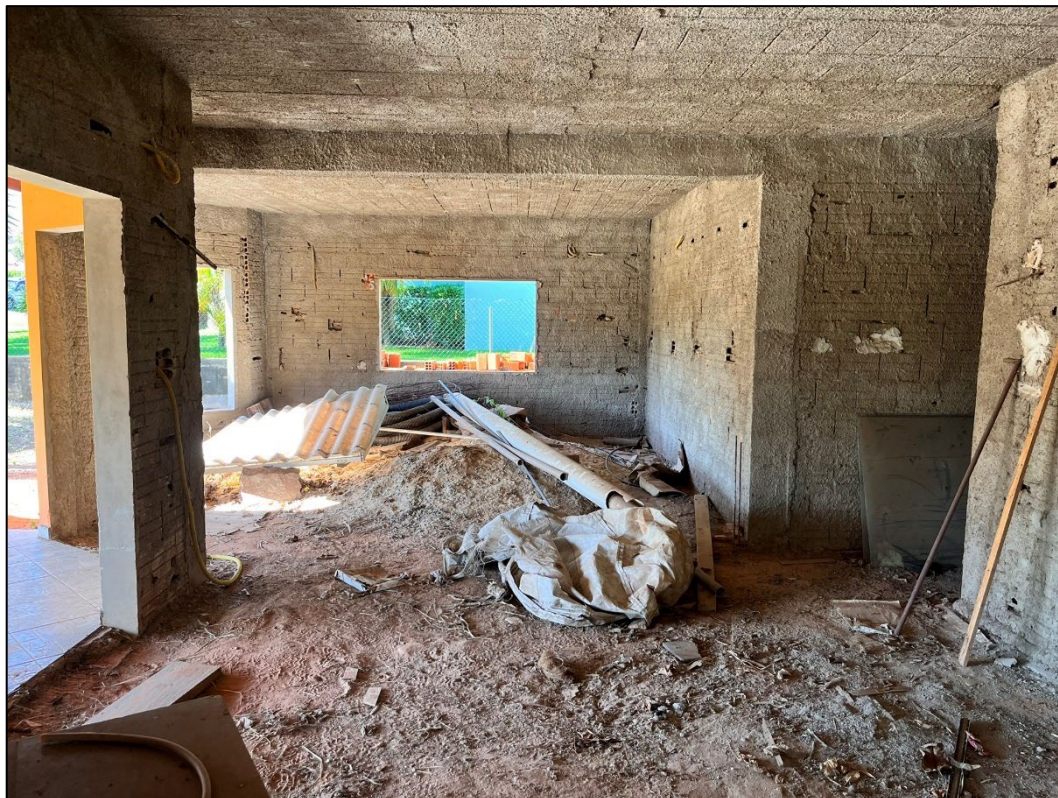
Figura 18 - Vista geral interna
