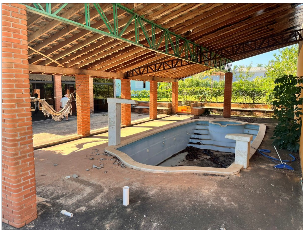
Figura 17 - Vista geral externa
