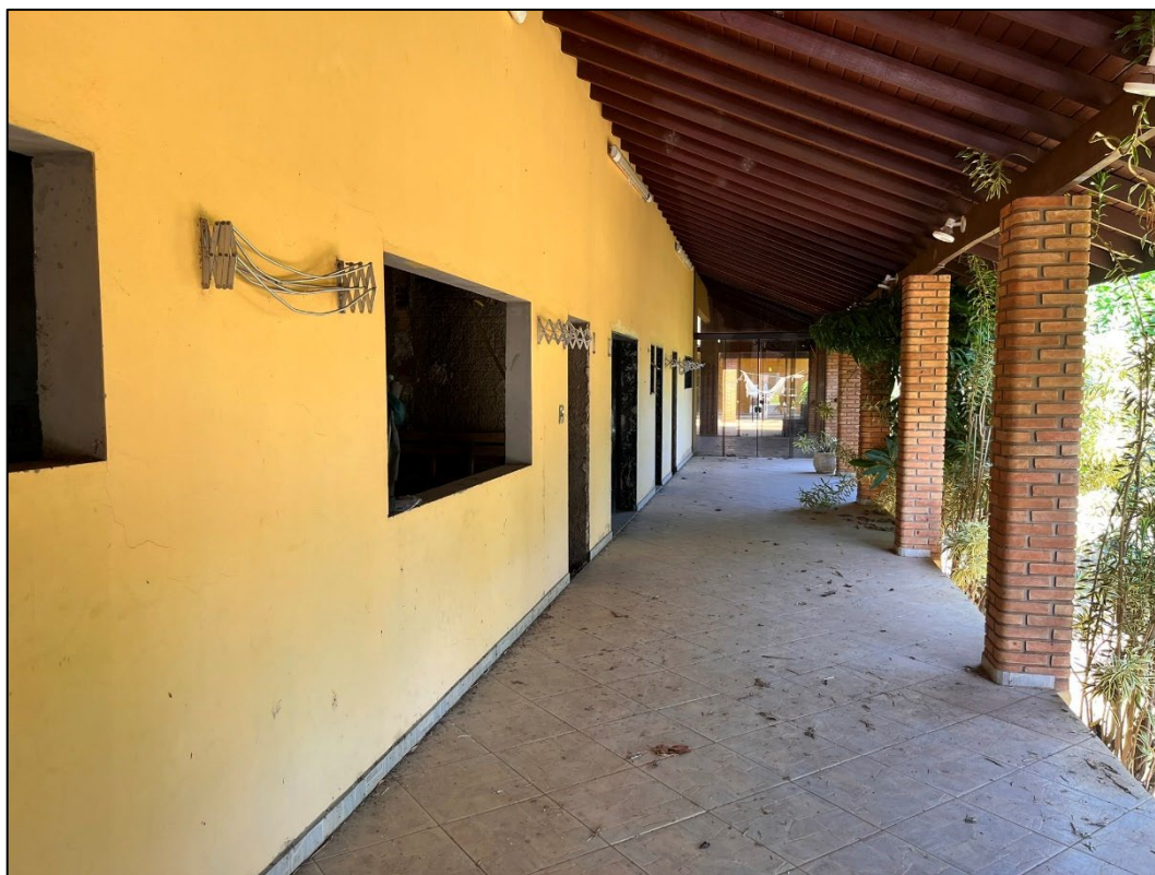
Figura 14 - Vista geral externa
