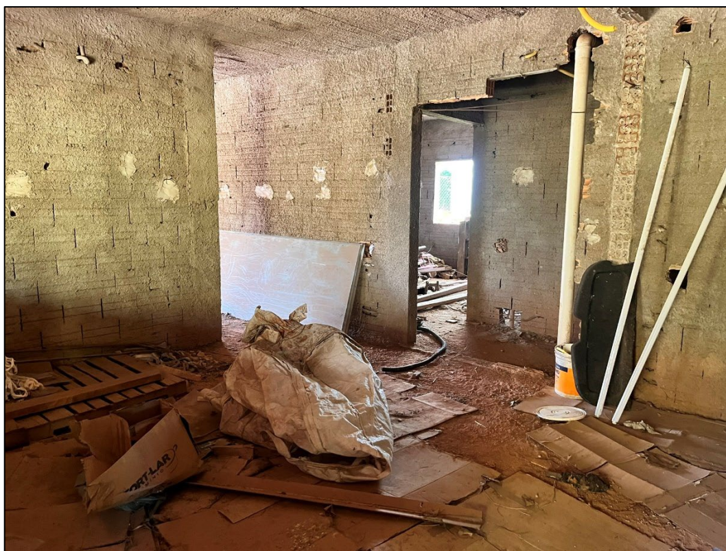
Figura 19 - Vista geral interna
