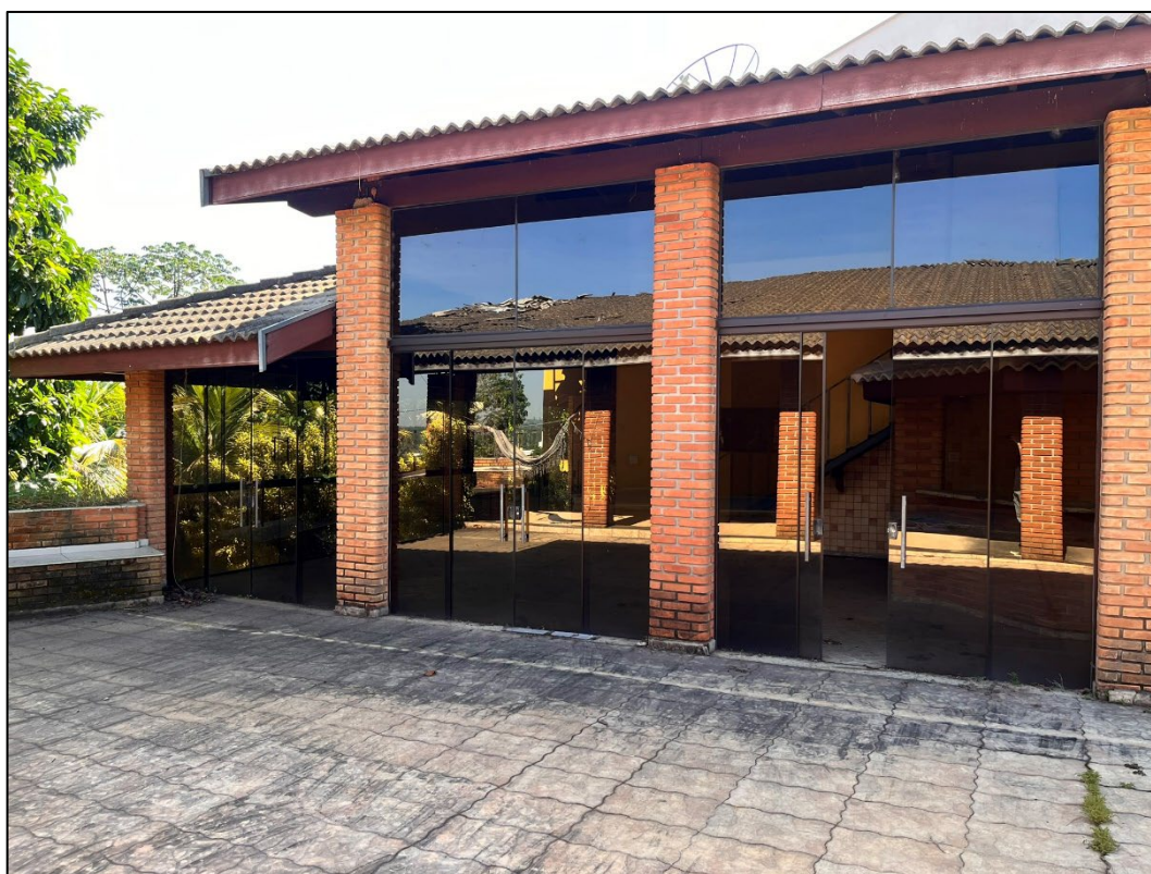
Figura 15 - Vista geral externa
