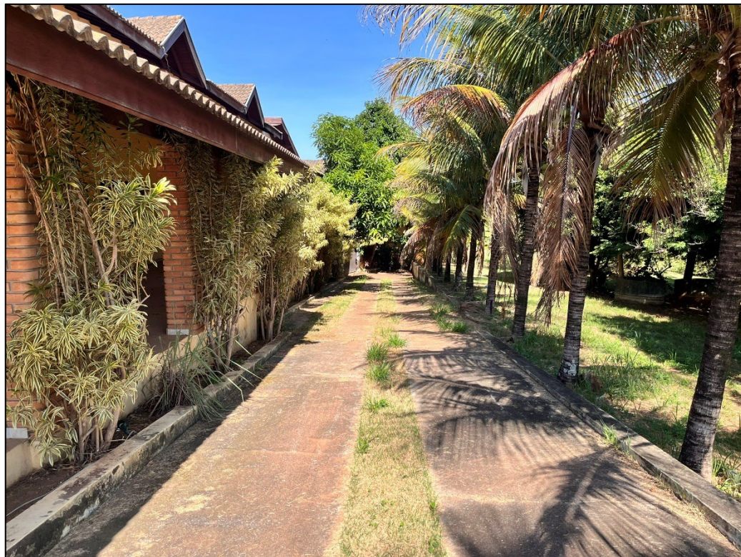
Figura 12 - Corredor área externa
