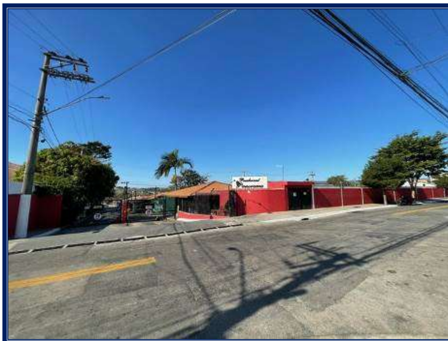
Vista geral da frente do Residencial Panorama onde se encontra localizado o imóvel avaliando.
